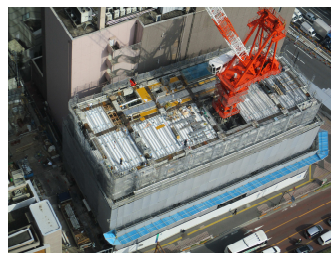
SB 棟の状況
